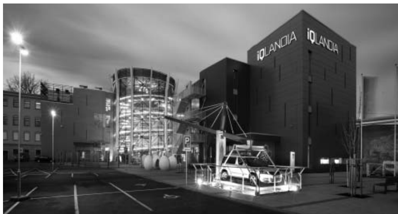
Obr. 41 a 42 Pohledy na budovu iQLANDIE – první obrázek je ještě vizualizace, druhý zachycuje objekt v reálu (foto archiv iQLANDIE)
