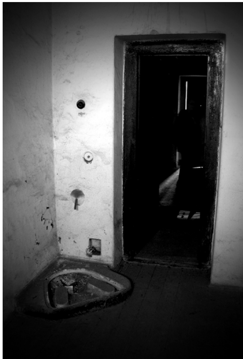
Obr. 72 Projekt Stěny věznice , foto archiv autorky projektu Lucie Kašné
